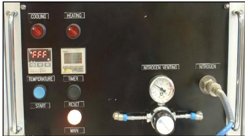
Figura 3-9: Foto dell'esterno del quadro.
