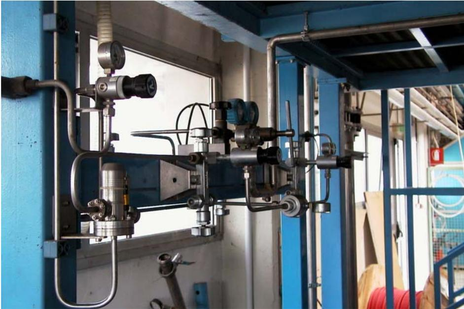
Fig. 2.5 Gruppo riduttori gas per atmosfera controllata
