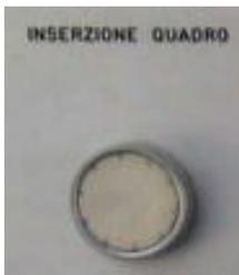
**inserzione quadro**: abilita i comandi presenti sul pannello di controllo dopo che è stato abilitato il circuito di comando
