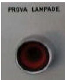
**prova lampade**: test di funzionamento delle luci di segnalazione
