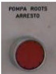
**arresto pompa roots:** arresta la pompa roots del gruppo pre-vuoto
