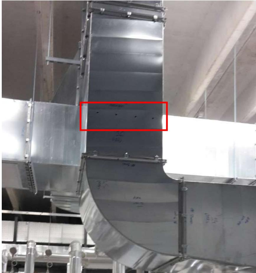
Figura 3.8 - Fori sulle canalizzazioni per settaggio UTA
